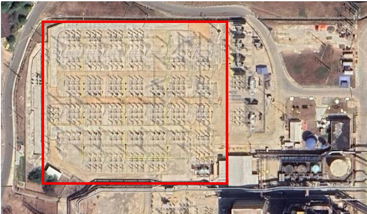
Figura 1. Vista satelital Subestación TEBSA 220kV.
